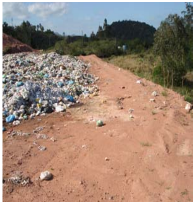
Figura 06 – Um espaldão contém os resíduos, mas não há isolamento para conter o percolado
