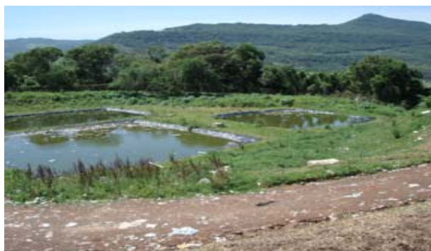
Figura 03 – Lagoas de recolhimento e contenção do chorume Fonte: Pesquisa realizada
